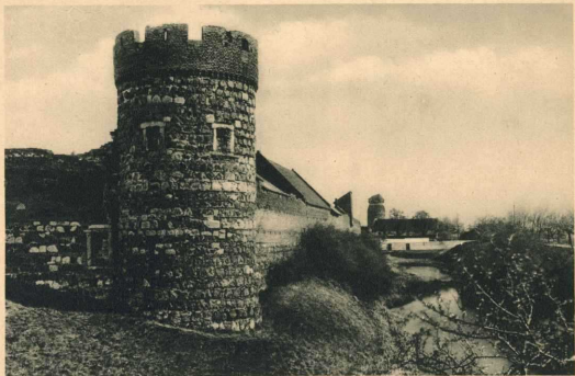
Zooß am Rhein, Westmauer mit Kröschenturm
