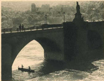
Heidelberg, Alte Brücke und Schloß
