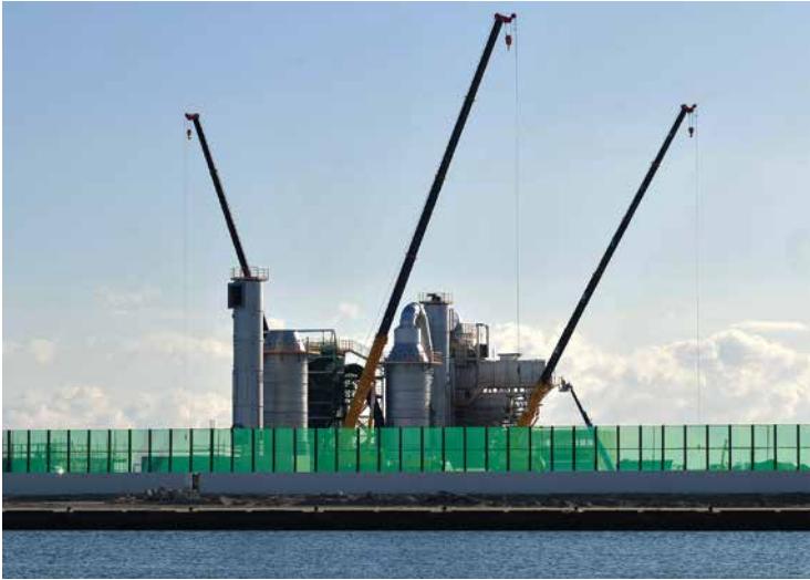
閑上港、がれき処理施設
