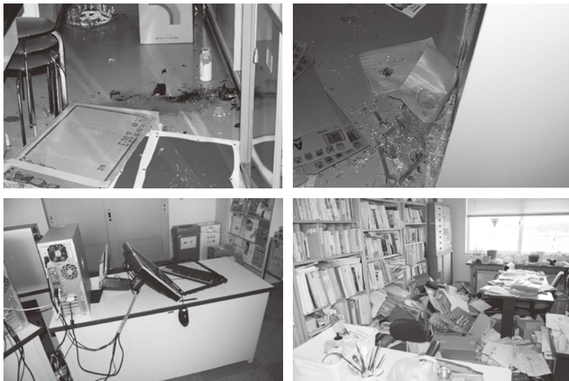
実験室、研究室等の被害状況
