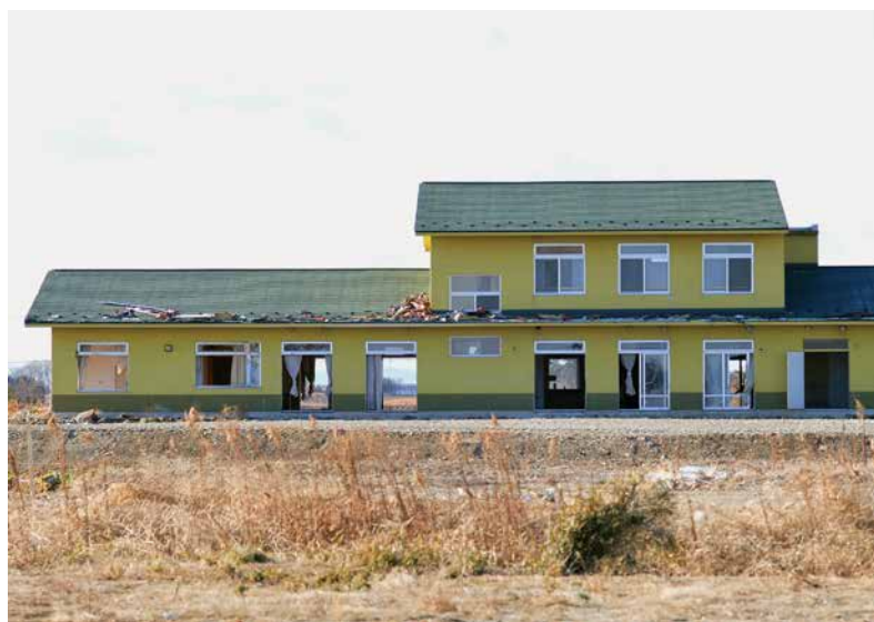
外壁のみ残り、屋内は空洞となった老健施設
