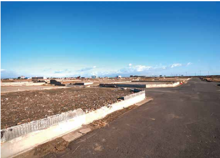
土台だけが残った住宅（2012年2月）
