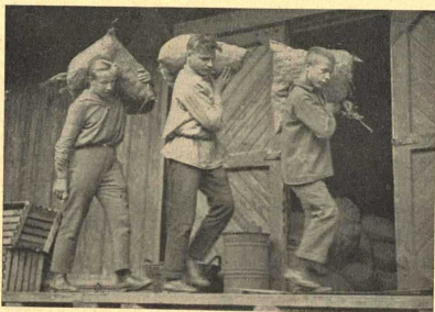
Moskauer Jungkommunisten haben eine Stößbrigade gebildet, um bei den Entlastungsarbeiten der Eisenbahnknotenpunkte, die infolge der guten Ernte stark überlastet waren, zu helfen.
