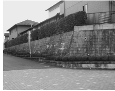
写真8 敷地とPBの境界が法面の事例
