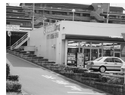
写真6 事業所の敷地内のPB
