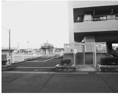
写真7 車の接触が多い駐車場付近のPB
